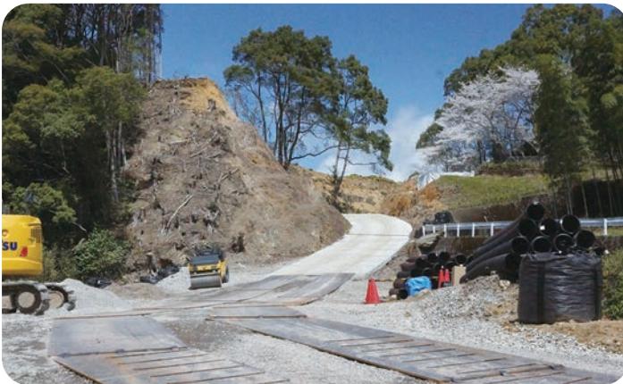
船津地内現場
