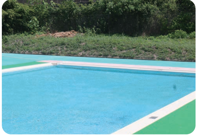
川辺東小学校プールフェンス設置予定箇所
