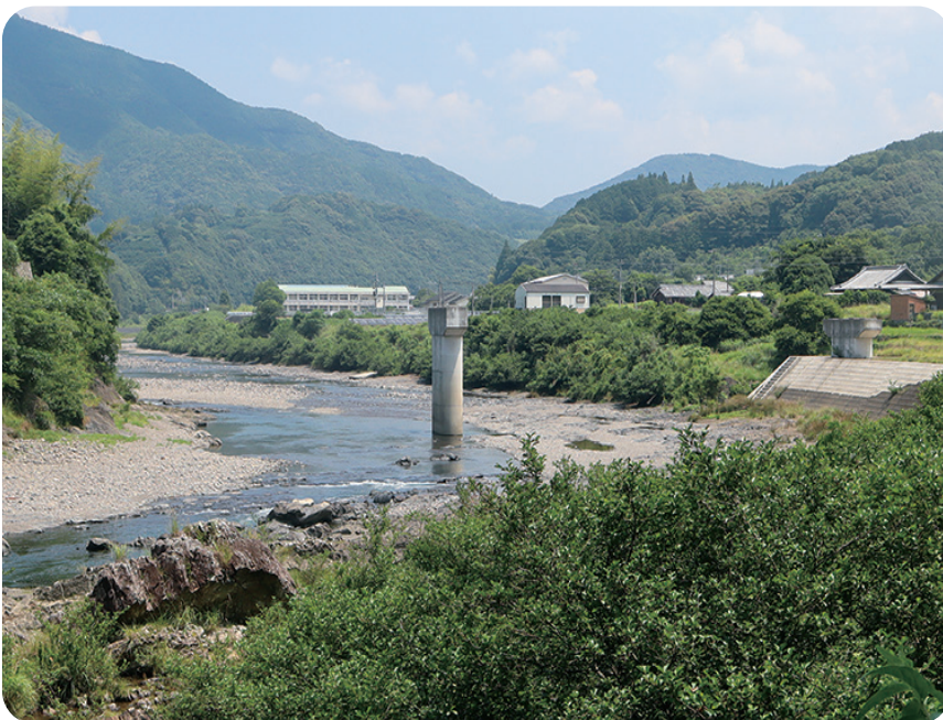
畑ヶ瀬橋 橋梁上部工事
