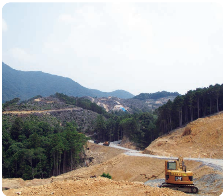
メガソーラー工事現場
