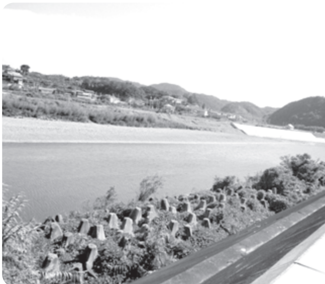
日高川の河川整備
