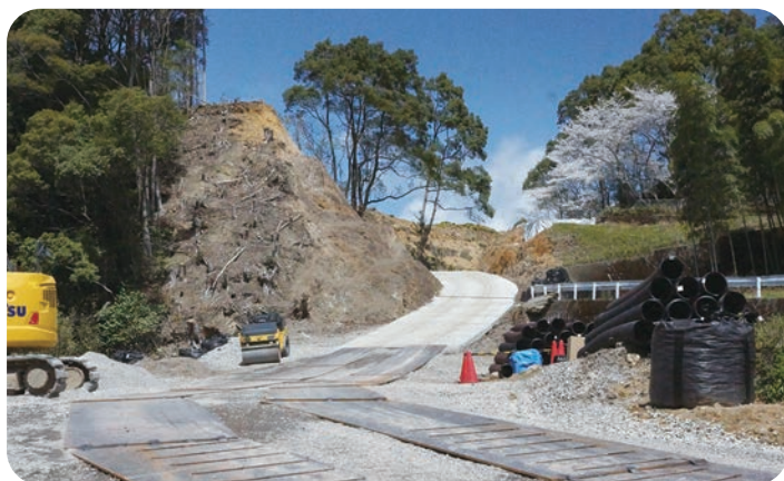
船津地内現場
