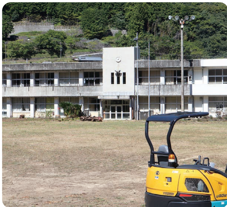
旧子十浦小学校解体工事
