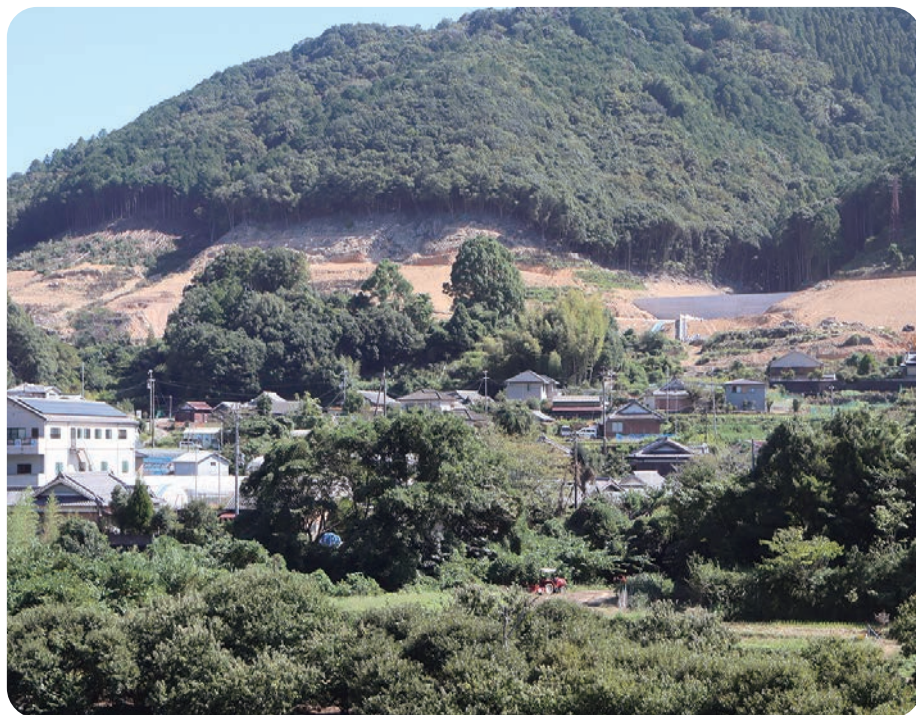
船津メガソーラー建設現場
