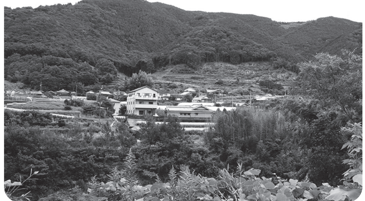
船津メガソーラー施工地
