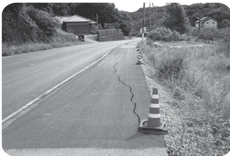
路面の陥没
