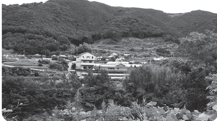
船津メガソーラー施工地
