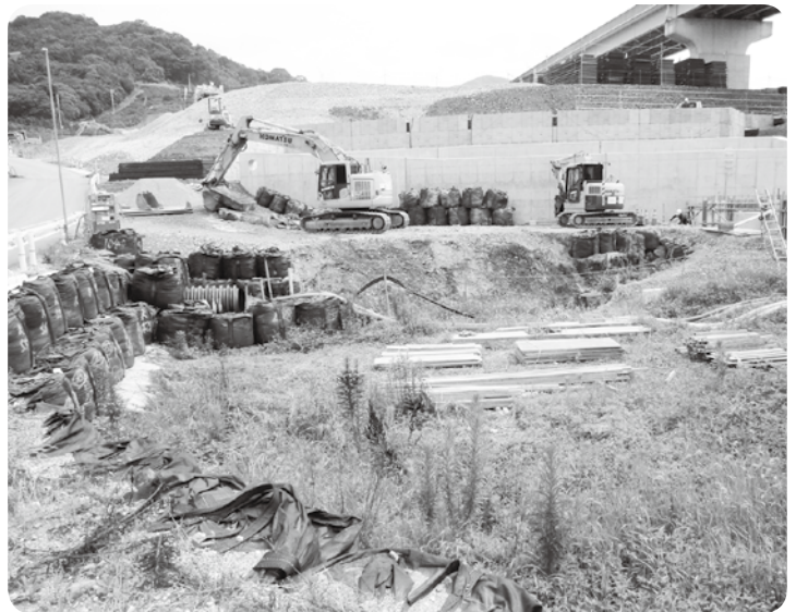
川辺インターのフルインター化工事現場
