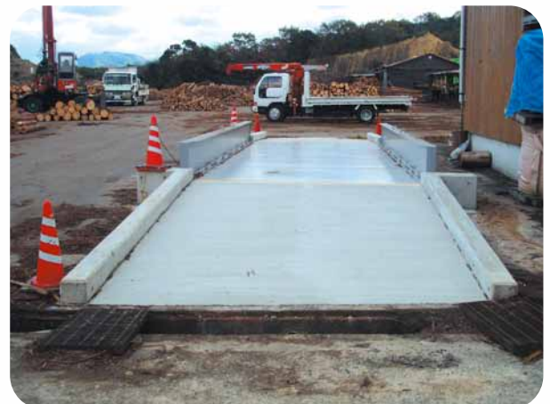
トラックスケール
