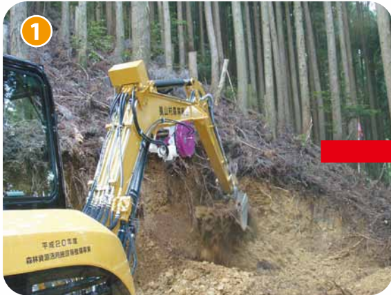
バックホー(作業道開設)
