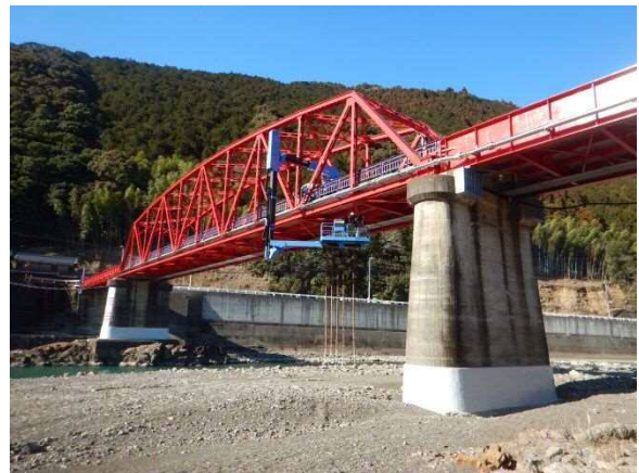
写真-2：川上橋 橋梁点検状況
