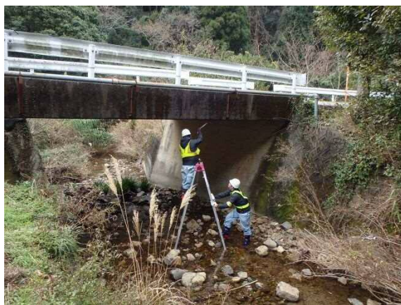
写真-1：赤木橋 橋梁点検状況
