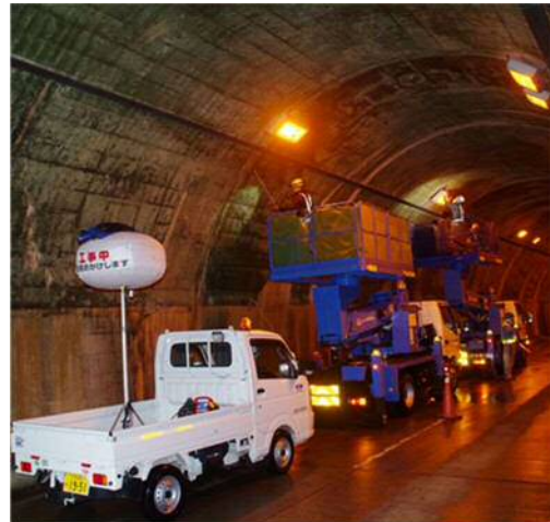
写真-2：糠越隧道 点検状況
