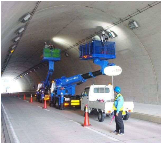
写真-1：土生トンネル 点検状況
