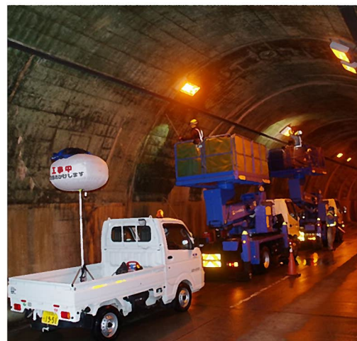
写真-2：糠越隧道 点検状況
