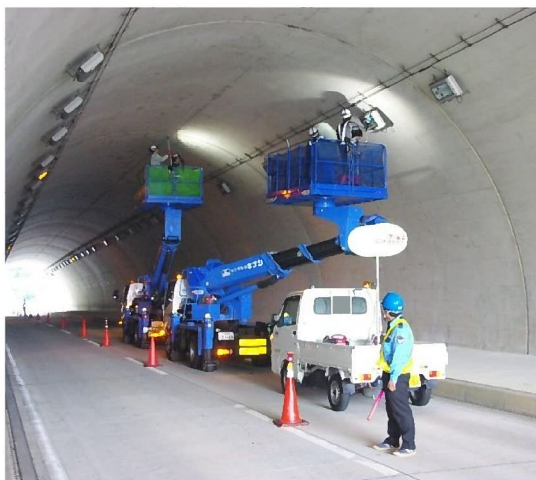
写真-1：土生トンネル 点検状況
