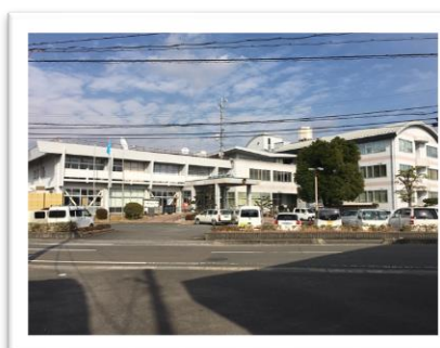
日高川町役場本庁舎
