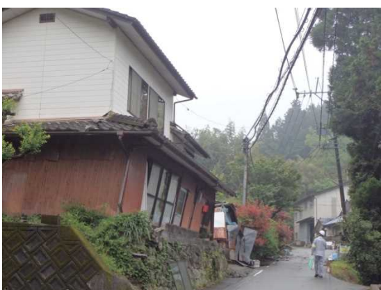
熊本地震の被災家屋（西原村）
