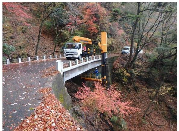
写真-8：叶橋 橋梁点検状況
