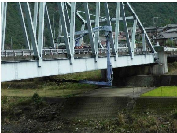
写真-7：下田原大橋 橋梁点検状況
