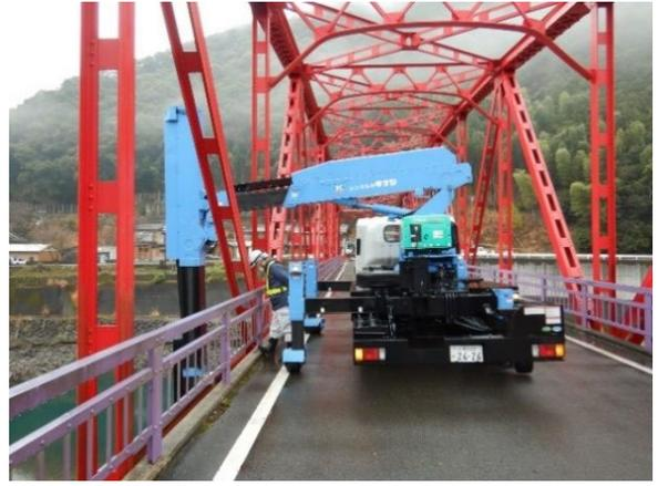
写真-2：川上橋 橋梁点検状況
