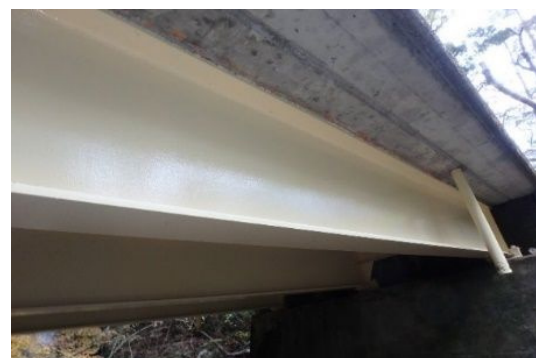
写真-12：松尾橋 補修後状況
