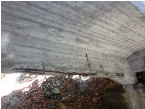
写真-9：石楠花橋 補修前状況
