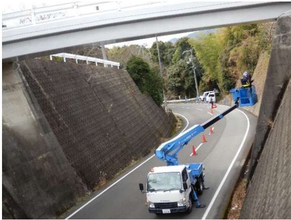
写真-3：上山橋 橋梁点検状況
