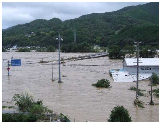
紀伊半島大水害(平成 23 年)
