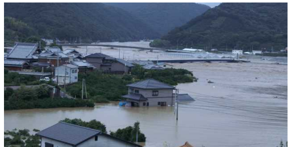
紀伊半島大水害(平成 23 年)
