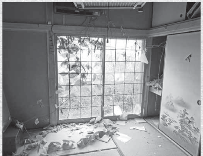
当該空き家の屋内の様子
