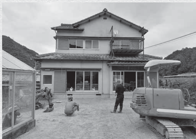
再生中の空き家に駐車場が出来ました
