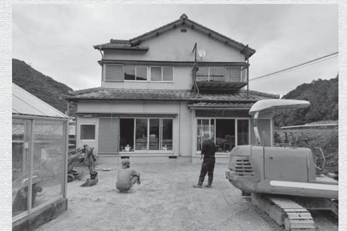
再生中の空き家に駐車場が出来ました
