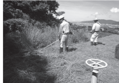
大山配水池での作業の様子
